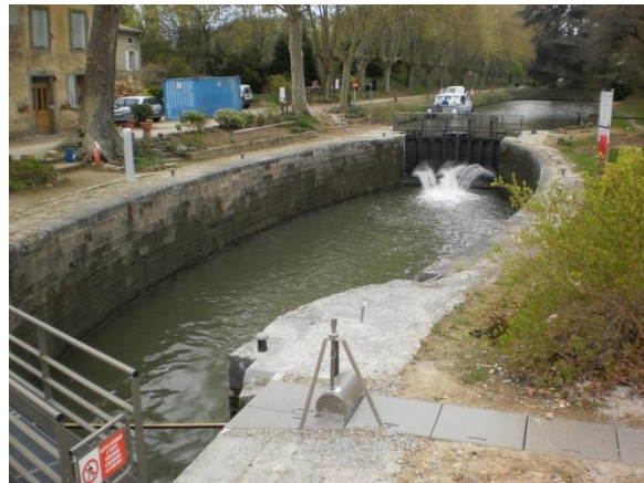
Die „écluse de l’océan“
