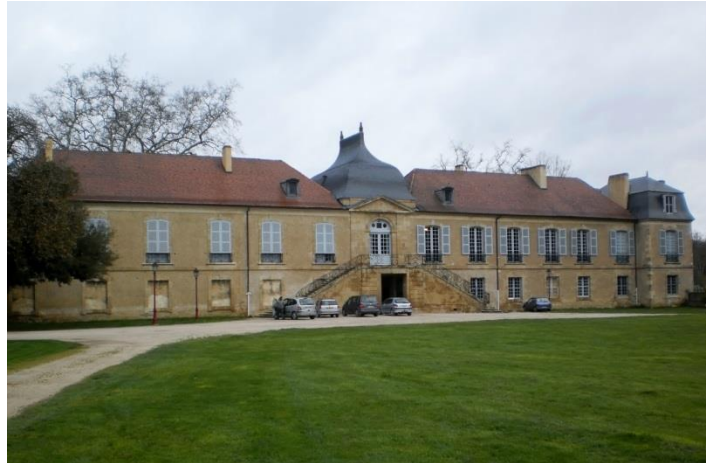
L'Isle-de-Noé – das Château
