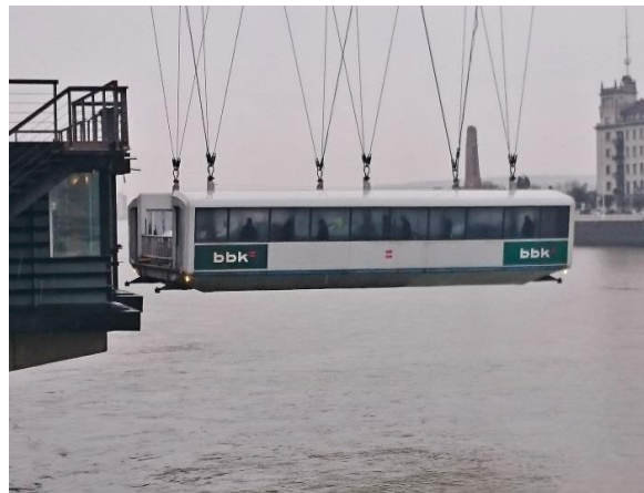
Die Hängebrücke mit Schwebefähre
