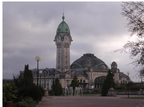
Das Bahnhofsgebäude in Limoges
