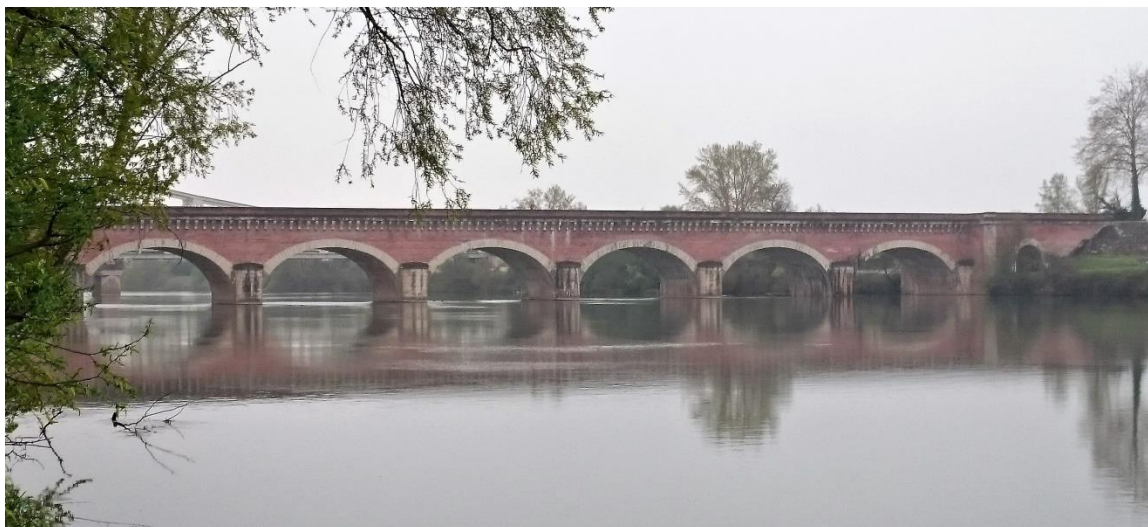
Die Kanalbrücke über den Tarn
