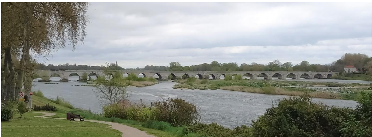
Die historische Loire-Brücke in Beaugency
