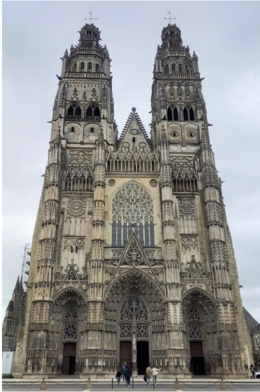
Die spätgotische Fassade
